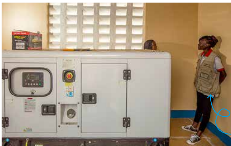
De duurzame watervoorziening van Cordaid. Met zonne-energie wordt water opgepompt en verdeeld over verschillende tappunten. Als de zon even niet schijnt, zorgt deze generator ervoor dat schoon water ook dan beschikbaar blijft.
